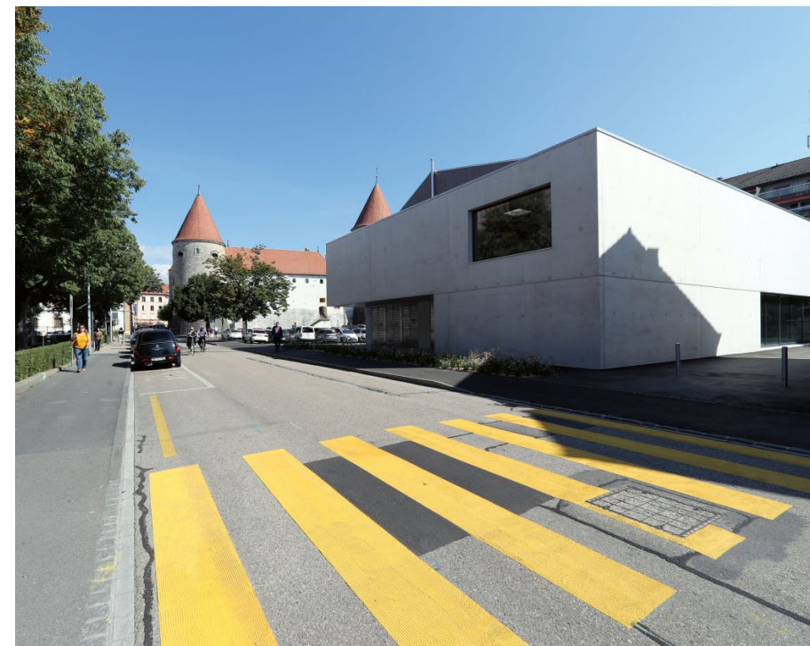
Réalisations électriques dans le cadre de la construction d'une salle de gymnastique à Yverdon
